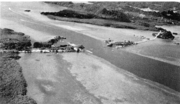
78 Bild 3. Gesamtansicht der eingestürzten Brücke
