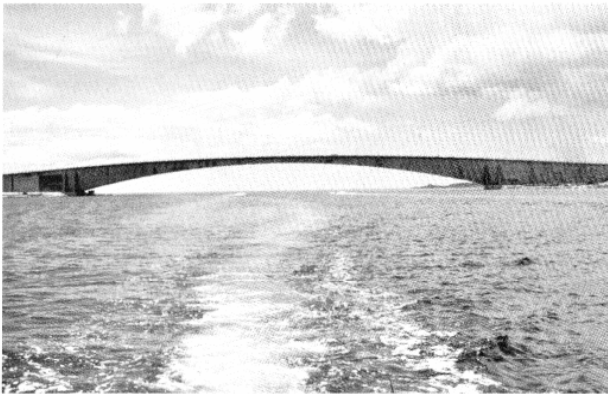
Bild 1. Koror-Brücke vor dem Einsturz
