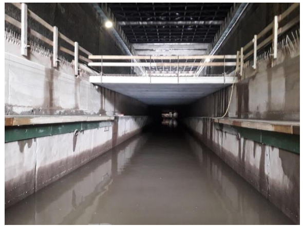
Herstellung Decke mit Fertigteilen und Aufbeton
