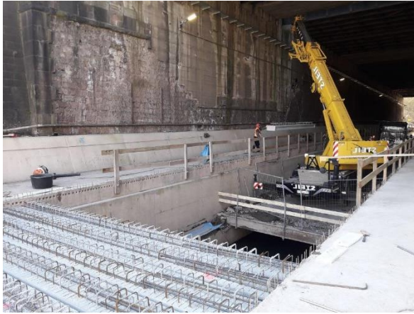
Herstellung Decke mit Fertigteilen und Aufbeton
