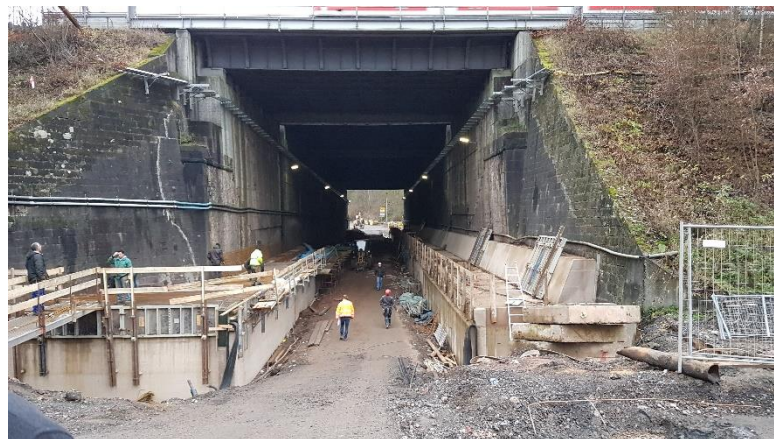
Herstellung Randbalken/Widerlager
