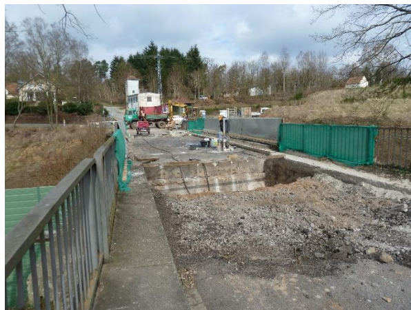
Vorbereitungen zum Abbruch
